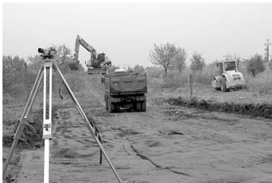
Zahájení stavebních prací v lokalitě Padělky.
