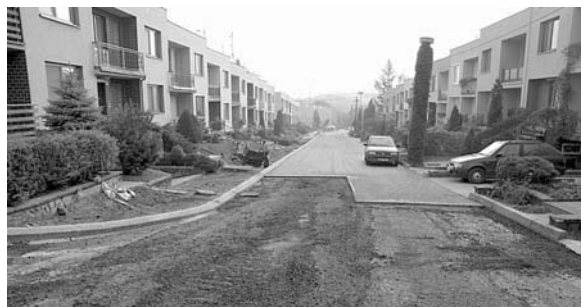
Na ulici Nová byla položena nová vozovka.
