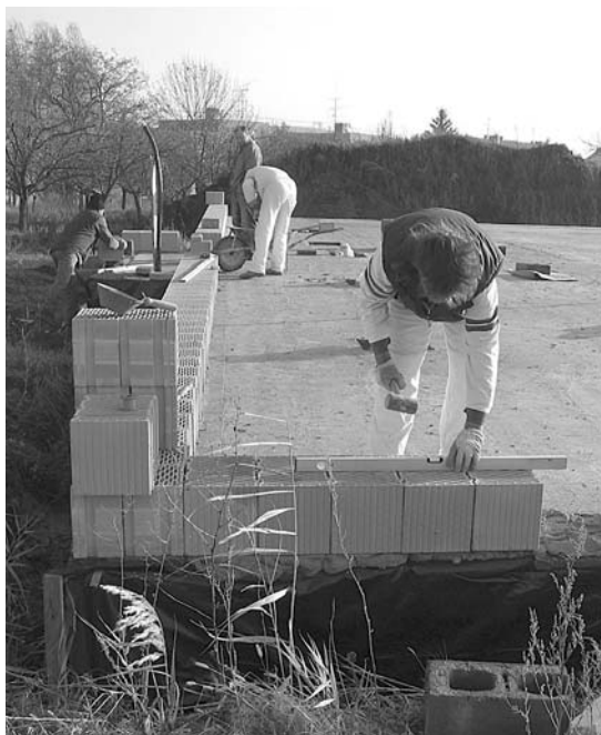
Stavba bytových domů byla zahájena ve svižném tempu. Nové byty budou hotové již na jaře příštího roku. Foto: Věra Procingerová
