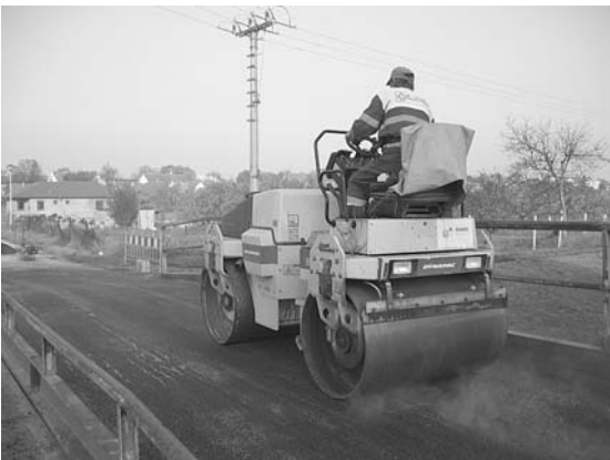
Nová asfaltka na mostě přes Trkmanku zaručí hladký průjezd. Foto: Karolína Bártová
