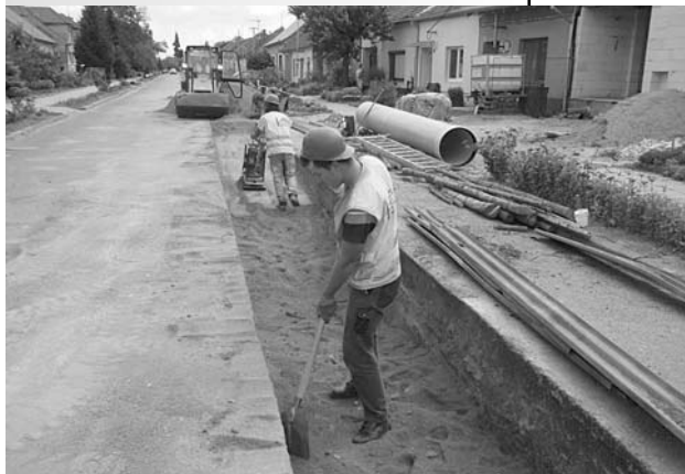
Práce na rekonstrukci kanalizace v ulici Pod Břehy.
