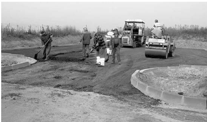
V horní části ulice při této příležitosti vzniklo parkoviště s 20 parkovacími místy. Foto: Ing. Zdeněk Karber
